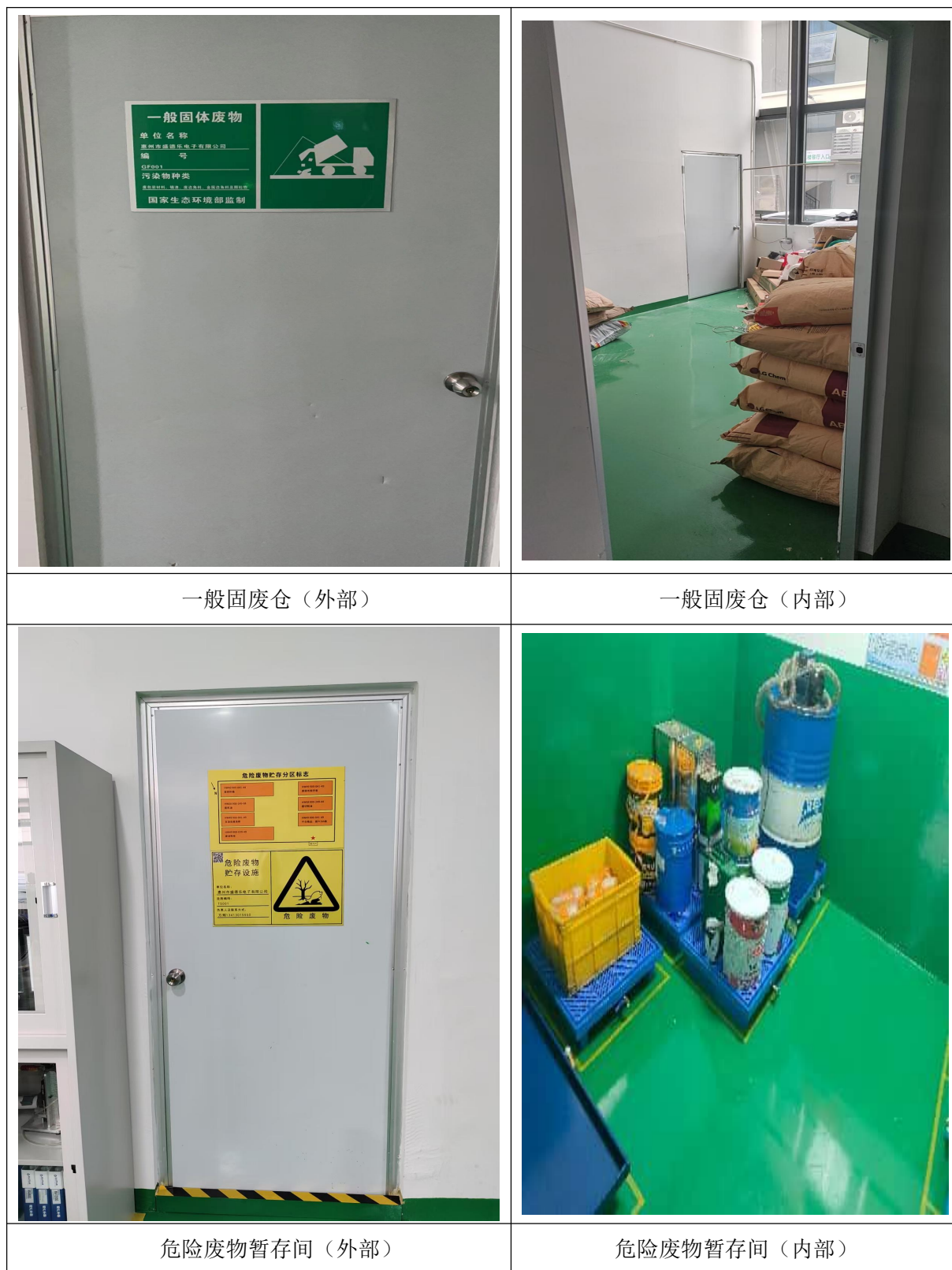
图 4-3 固体废物暂存场所
