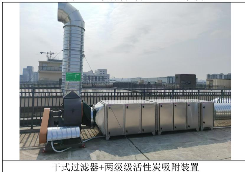
图 4-2 废气处理装置
