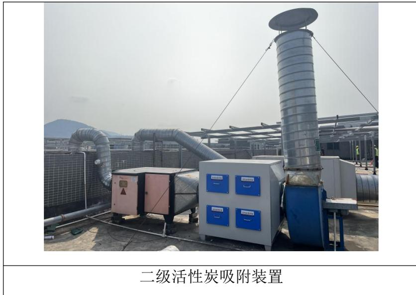
图 4-2 废气处理装置
